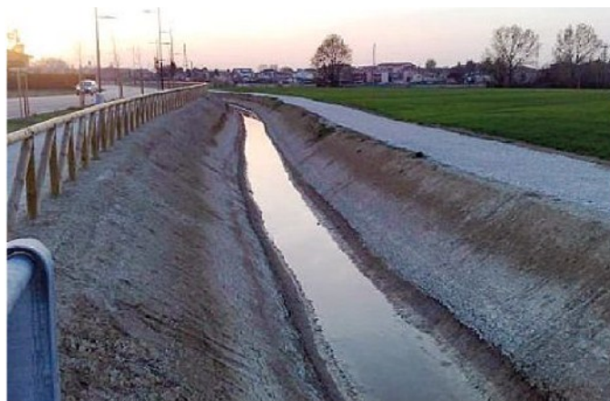
Il canale scavato che corre a fianco della Vallenari bis
